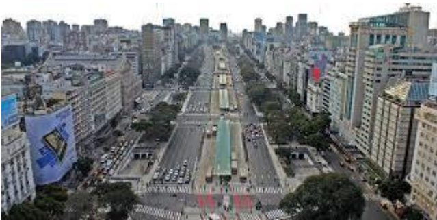
Aspecto actual, expropiación finalizada
